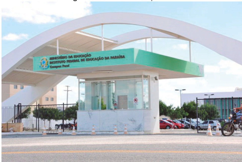
Figura 1. Entrada do IFPB Campus Picuí.
